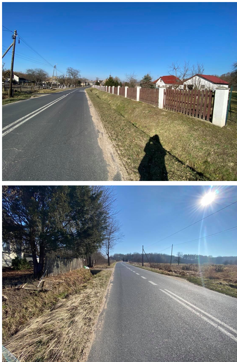
Widok na drogę dojazdową
