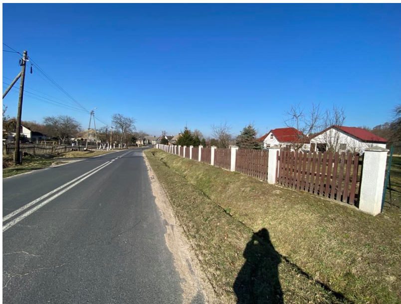
Widok na drogę dojazdową
