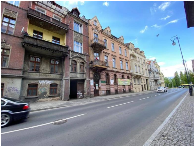
Widok na drogę dojazdową
