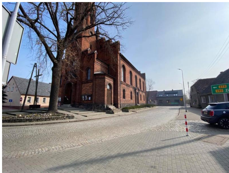
Widok na drogę dojazdową i otoczenie
