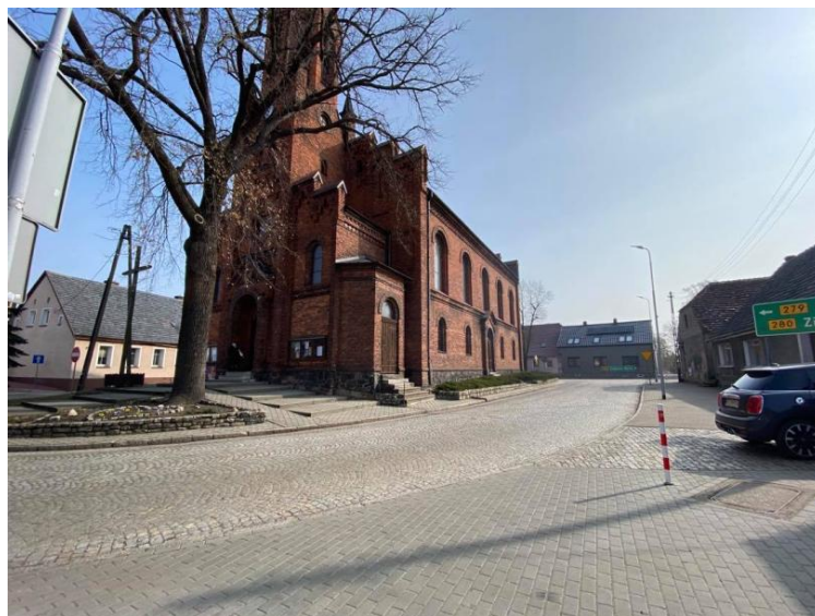
Widok na drogę dojazdową i otoczenie
