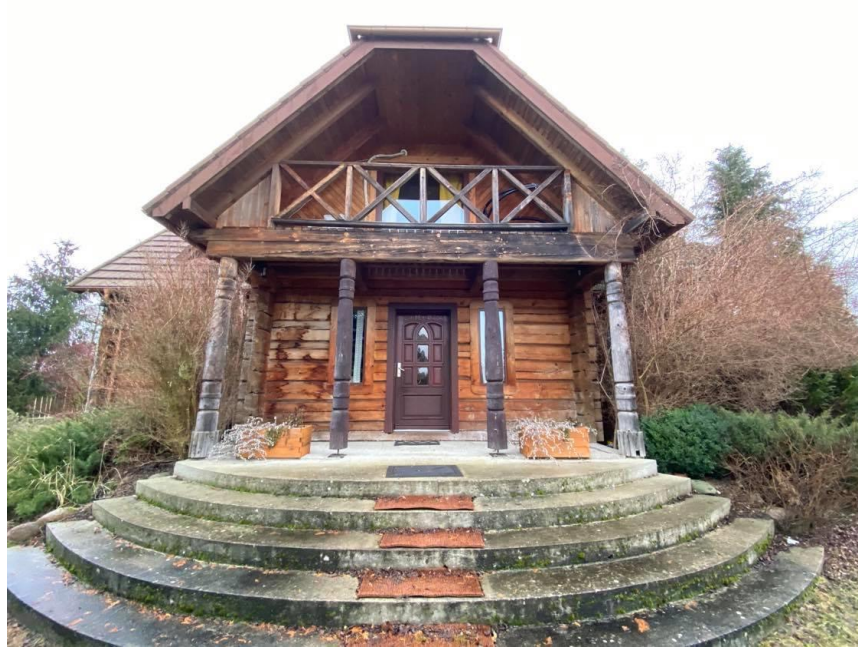
Widok na budynek
